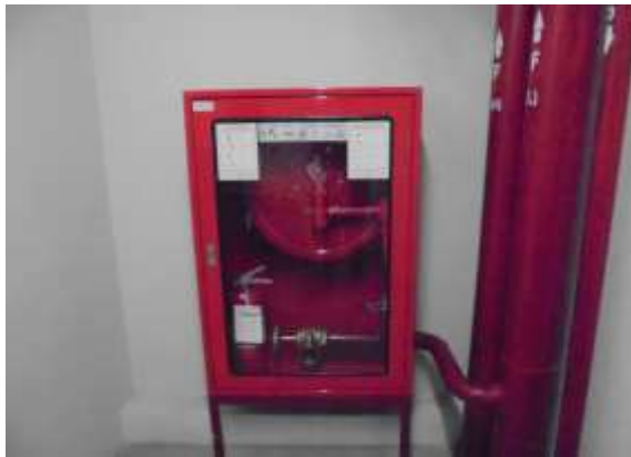
รูปที่ 15 ถังดับเพลิงเคมีแบบถือในตู้ FHC
