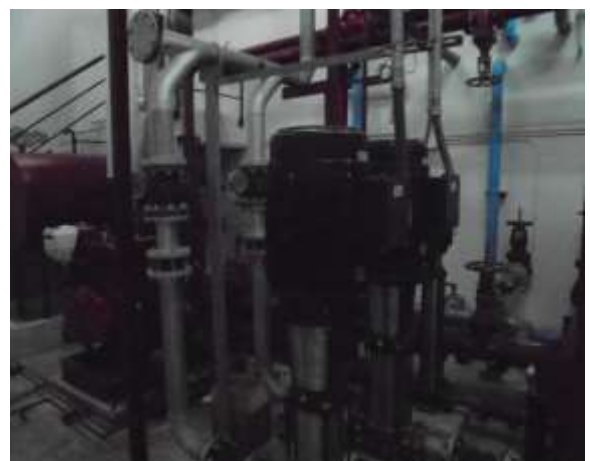
รูปที่ 24 ระบบสูบน้ำ
