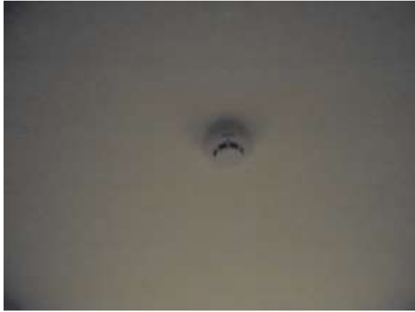
รูปที่ 13 เครื่องตรวจจับควัน
